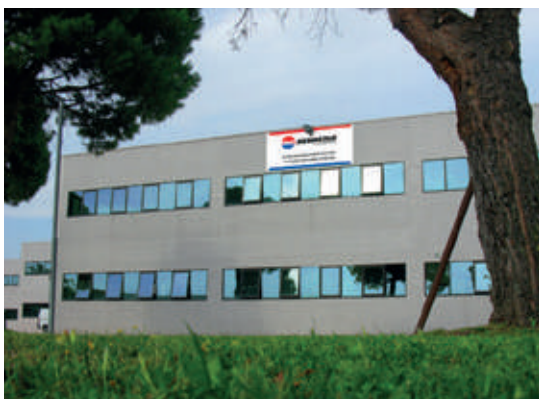
Nuovo Stabilimento New Cleaning Division
